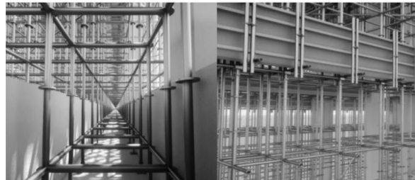
图5 盘扣式脚手架模型
