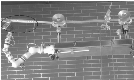
图 3 螺栓紧固带电作业机器人
