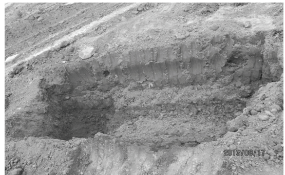
图 14 现场挖掘平底坑图片
